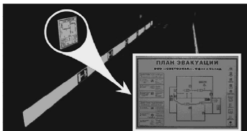
Рис. 5. Фотолюминесцентный план эвакуации
