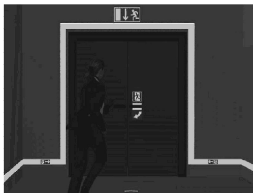
Рис. 2. Фотолуминесцентное обозначение двери эвакуационного выхода
