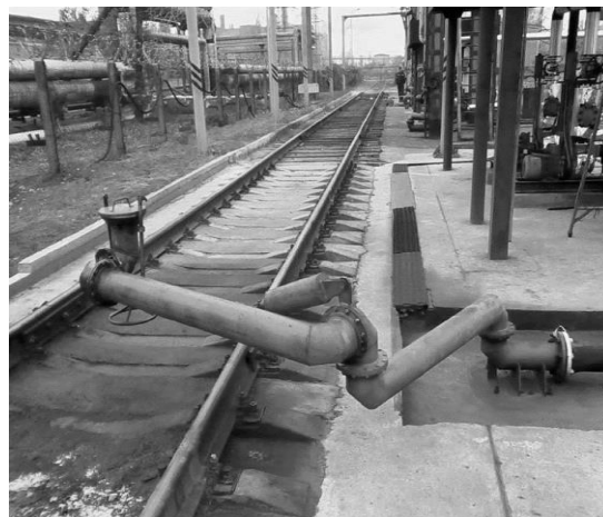
Рис. 1. Пятно нефтепродуктов в месте присоединения устройства слива-налива УСН к железнодорожной цистерне
