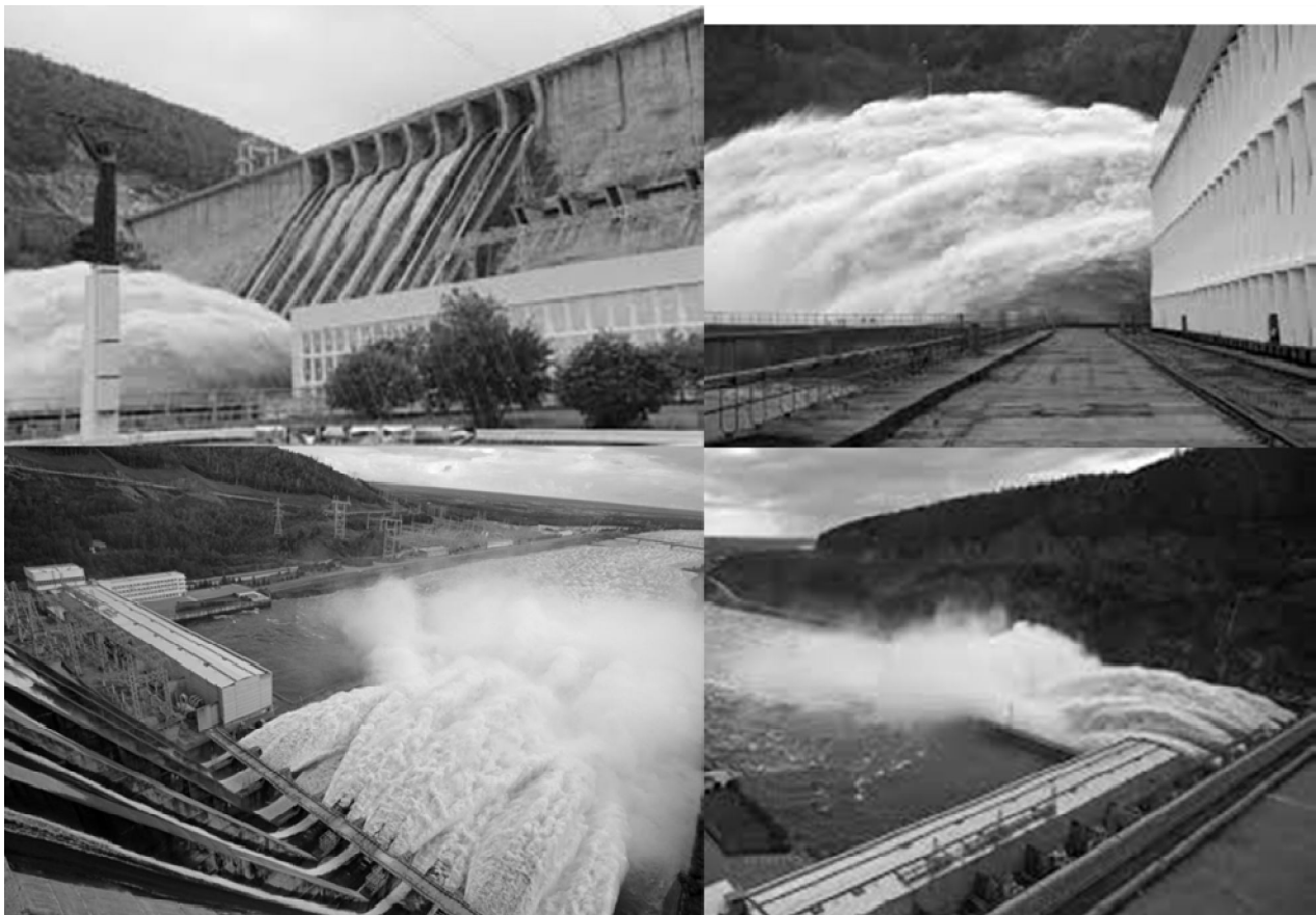
Рис. 4. Холостые сбросы на Зейской ГЭС
