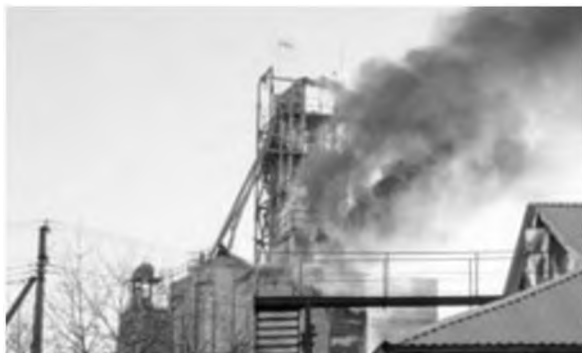
Рис. 3. Пожар на зерносушилке ОАО «АгроТерра-Элеватор» в Становлянском районе Липецкой области, 27.01.2018 г.
