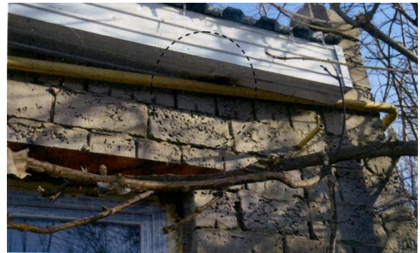
Рис. 9. а) Место контакта неизолированного провода с кровлей здания; б) Место контакта металлических элементов кровли с газовой трубой
