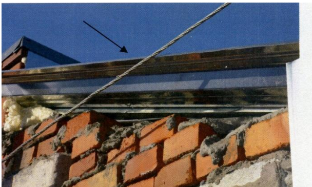
Рис. 9. а) Место контакта неизолированного провода с кровлей здания; б) Место контакта металлических элементов кровли с газовой трубой
