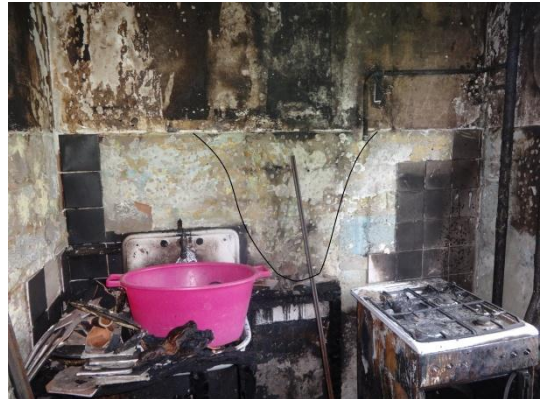
Рис. 6. Фото очаговой зоны (на стене отмечен очаговый конус)
