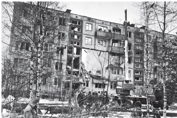
Рис. 2. Последствия взрыва газозвушной смеси в Приозерске (1996 г)
