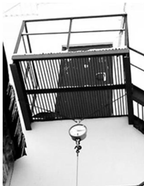
Рис. 1. Испытание площадки наружной пожарной маршевой лестницы
