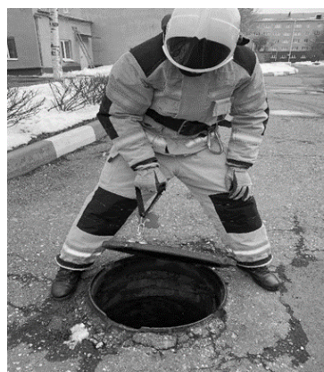
Рис. 3. Подъем чугунной крышки люка водопроводного колодца с помощью СМП-120
