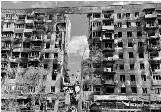
Рис. 1. Разрушение панельного здания
