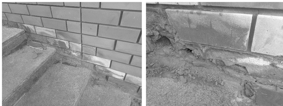
Рис. 1. Характер разрушения силикатного кирпича под воздействием антиобледенителей
