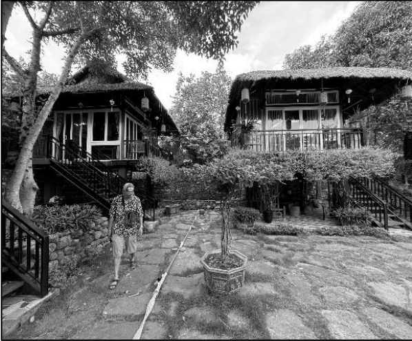
Рис. 3. Установка перфорированного стационарного трубопровода между жилыми сооружениями пониженной огнестойкости
