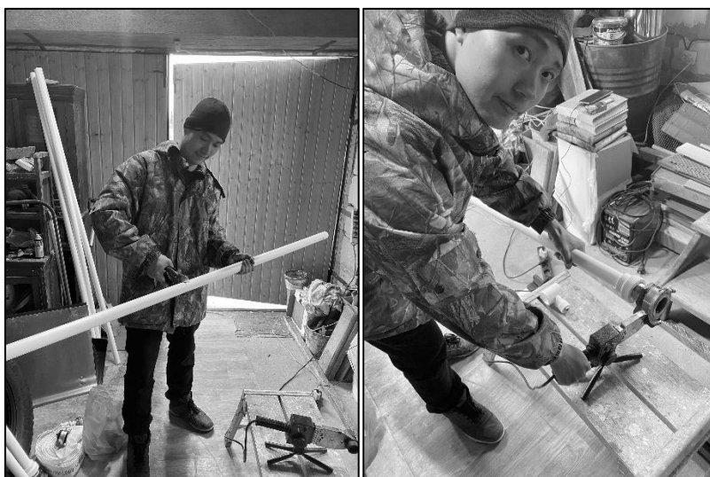
Рис. 2. Изготовление экспериментального образца перфорированного трубопровода с непрерывным расходом воды для стационарного использования
