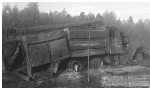
Рис. 1. Последствия пожара в ЛПДС «Конда» 1
