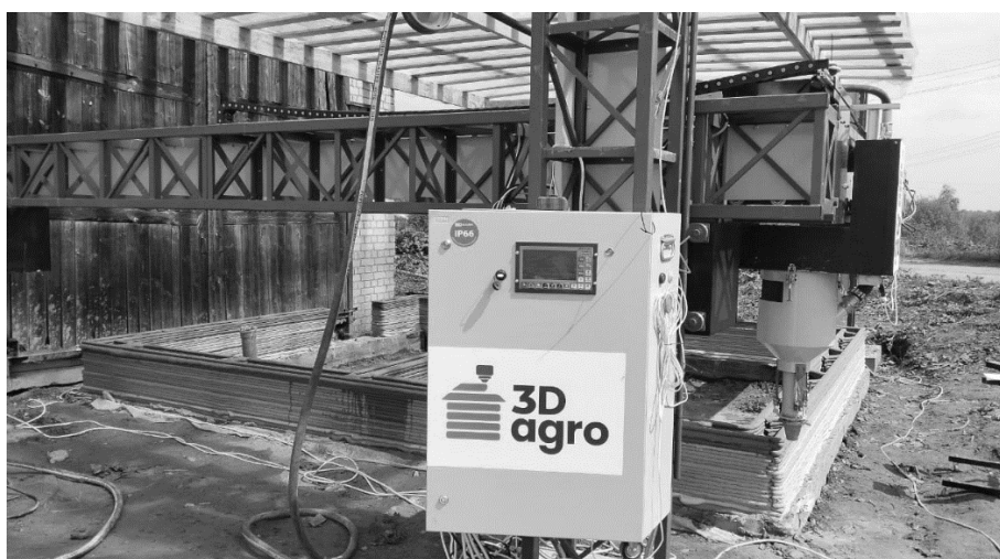
Рис. 3. Технология строительной 3D-печати стеновых конструкций из составов легких бетонов на органическом заполнителе из мискантуса сорта «Камис»
